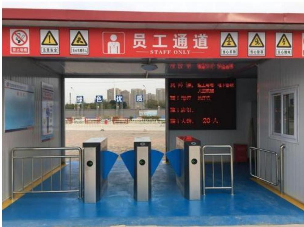
图 C-9 员工实名制门禁系统示例图
