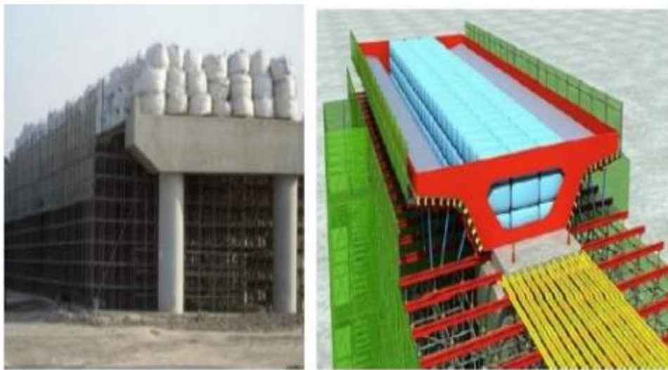
图 C-4 模板支架预压(示例)
